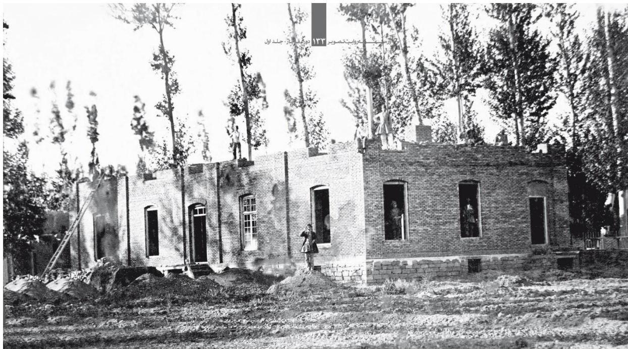
The American protestant Christians' hospital under construction outside of Urmia. Photographer: Ali Khan Vali, 1305 A.H. مرخصانه عیسویان پروتستانیها آمریکایی در حال ساخت در بیرون شهر ارومی ۱۳۰۵ قمری، عکاس علی خان والی
